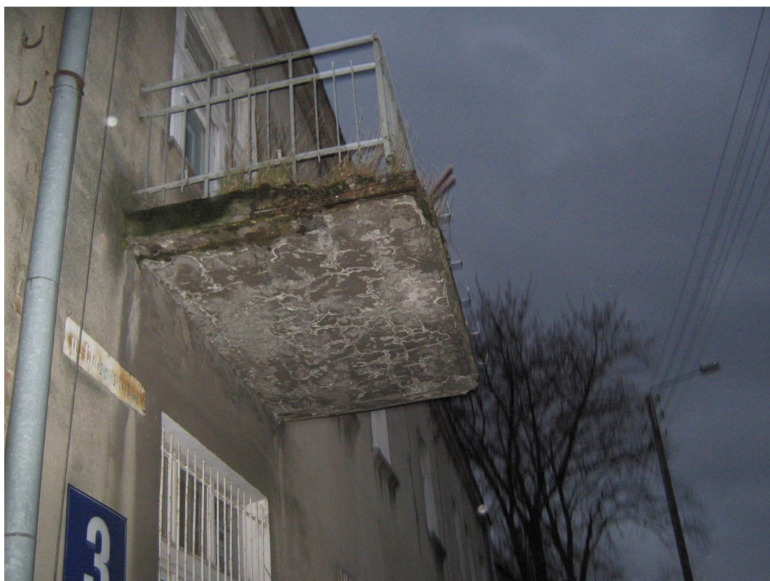
Uszkodzenia balkonu
