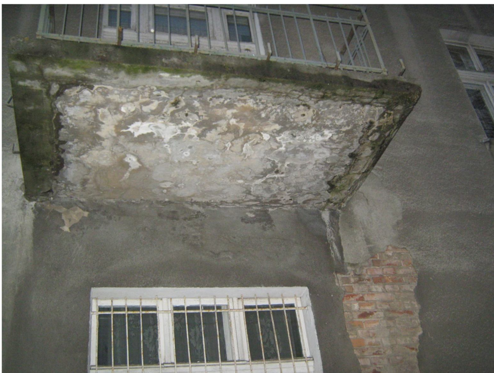
Uszkodzenia balkonu
